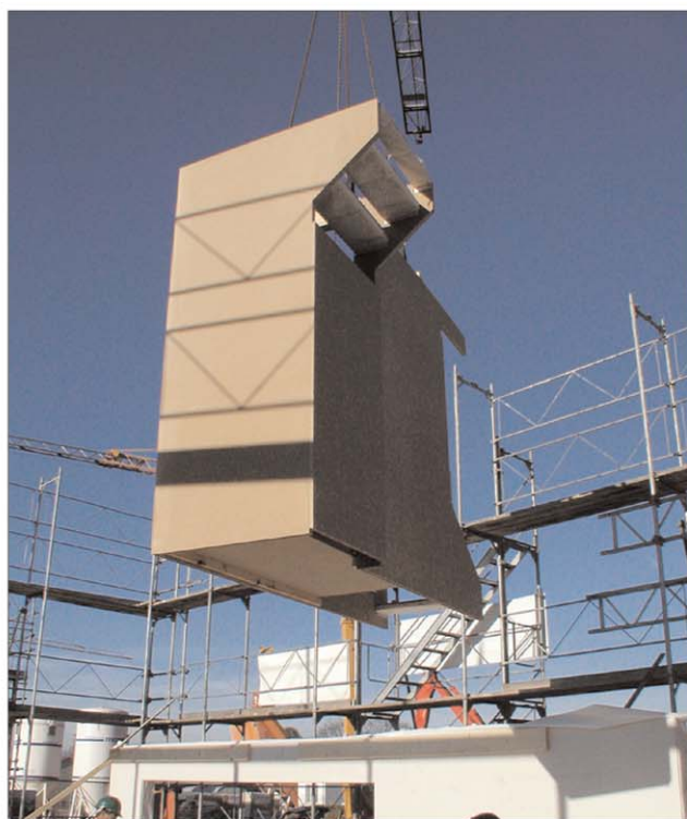
Stetig "wächst" der Bau mit dem Einsetzen neuer Elemente
