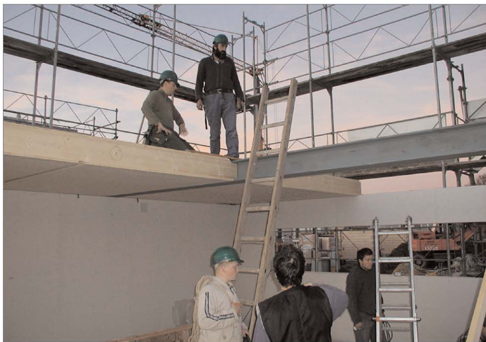
Schrittweise werden die Holzelemente von innen heraus eingebaut
