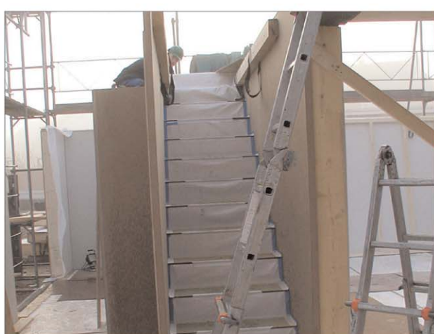
Das Einpassen der vorgefertigten Treppen verläuft reibungslos
