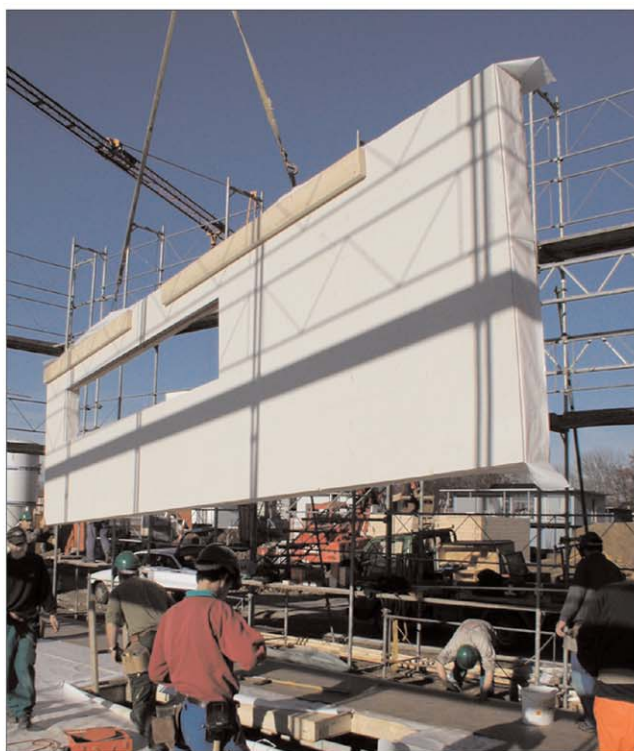
Vorfabrizierte Bauteile, wie diese Seitenwand.
