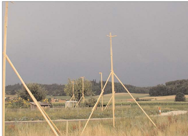
Bauprofile an der Roggenstrasse und dem Gerstenweg
