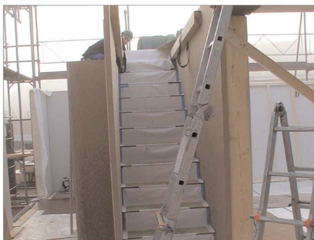
Das Einpassen der vorgefertigten Treppen verläuft reibungslos
